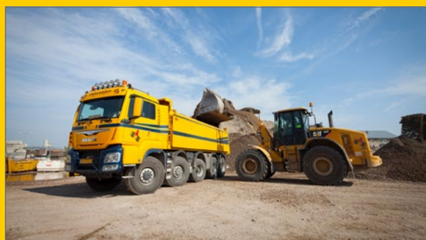
afvoer gecertificeerd puin
