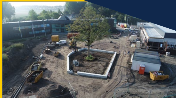
Heinkenszand nieuwbouw Lidl inclusief buitenterrein
