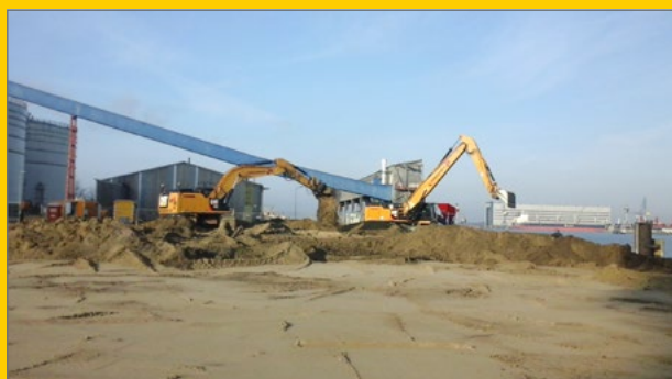
sanering haventerrein Vlissingen-Oost
